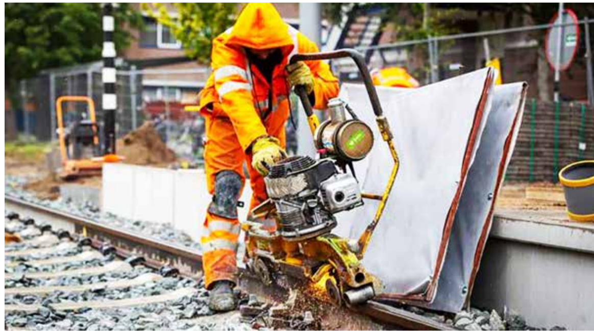
Het slijpen van de tramrails in beeld.
